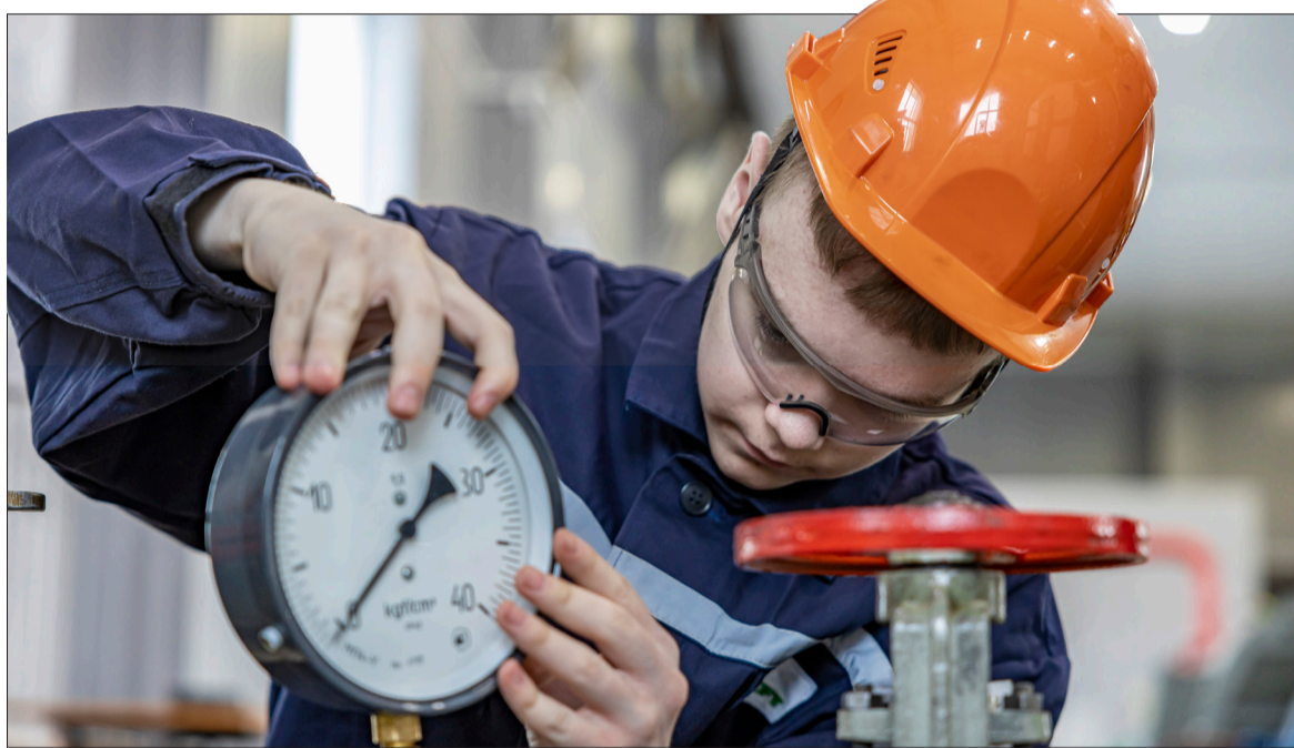
Замена манометра / ФОТО СЕРГЕЯ ТРУСОВА
