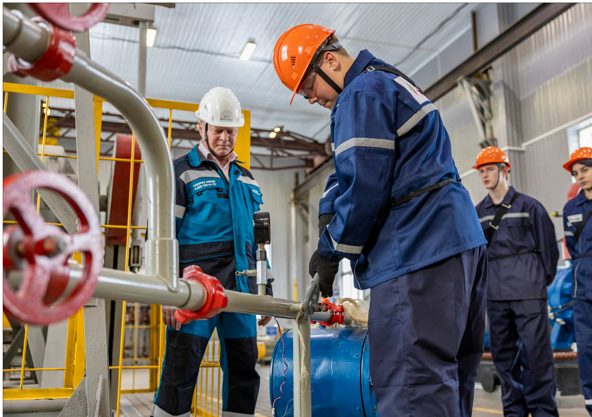
Замена пробоотборника на манифольде – одно из упражнений в рамках обучения по профессии «Оператор по добыче нефти и газа» / ФОТО СЕРГЕЯ ТРУСОВА
